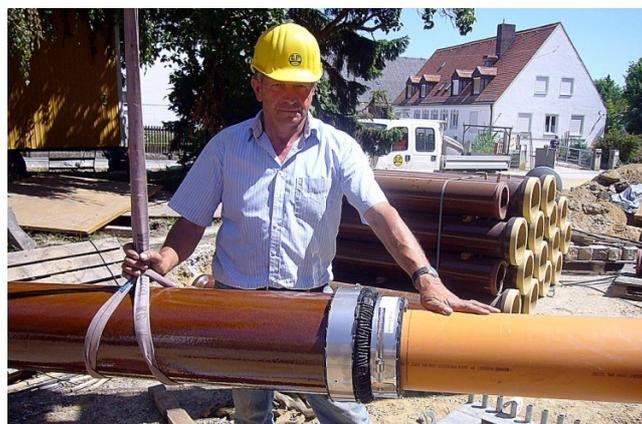
Die stufenlose Durchmesser-Anpassung erfolgt dabei unter zentrischer Reduktion und Sicherung der Scherlast. Die Verbindung ist auch im ausgewinkelten Anwendungsfall dauerhaft dicht und erfüllt alle einschlägigen Normen mühelos.
